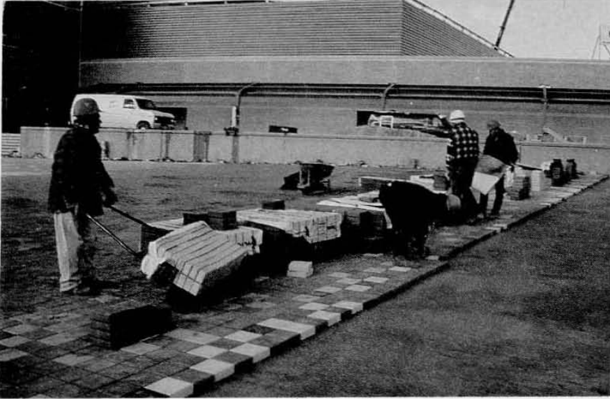
Figure 13. Construction. Figura 13. Construcción.
