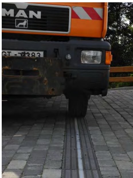
Bild 3. Belastungsversuch auf der Probefläche vor dem Klimapark Rietberg / Load test on the testing plant next to Klimapark Rietberg
